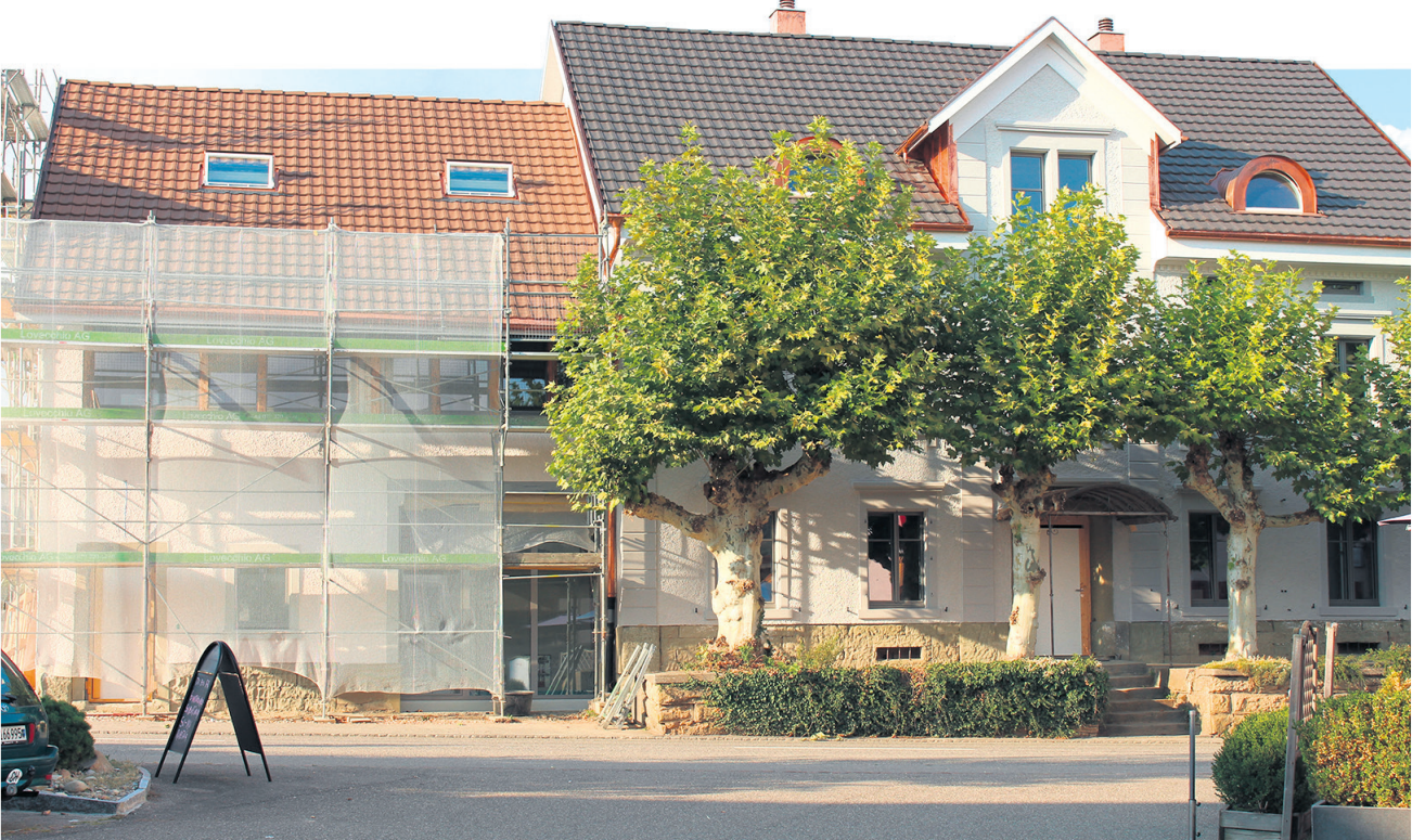
Auch in seiner neuen Optik hat das ehemalige Kolonialwarenhaus viel von seinem früheren Charme behalten. Foto: Simone Ruffi
