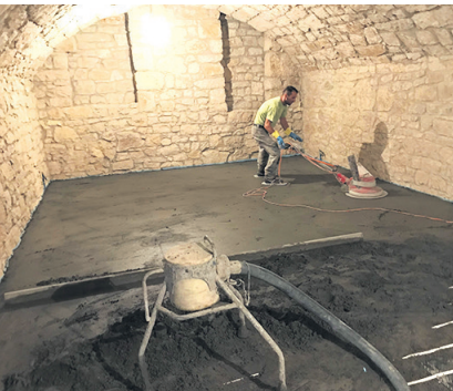
Der Gewölbekeller wird hergerichtet. Foto: zVg
